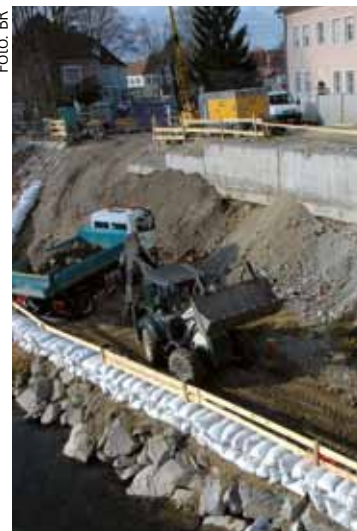
Bis Ende April werden die Bauarbeiten fertiggestellt.
