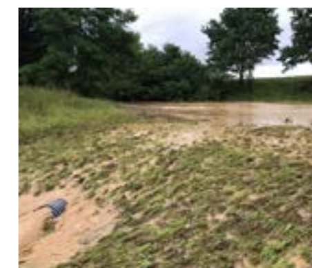
Kutschenitza / Rückhaltebecken Zeltling
