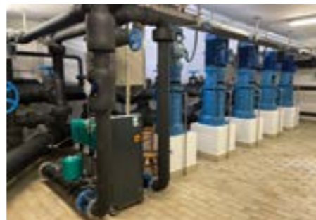
Drucksteigerung und UV-Desinfektion im Wasserwerk
