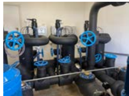
Drucksteigerung und UV-Desinfektion im Wasserwerk
