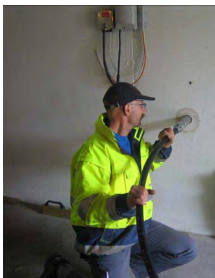
Abbildung 41: Ansetzen einer Erdrakete im Keller
