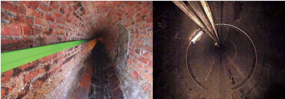
Abbildung 39: LWL-Verlegung im Abwasserkanal (metallfrei und metallisch)
