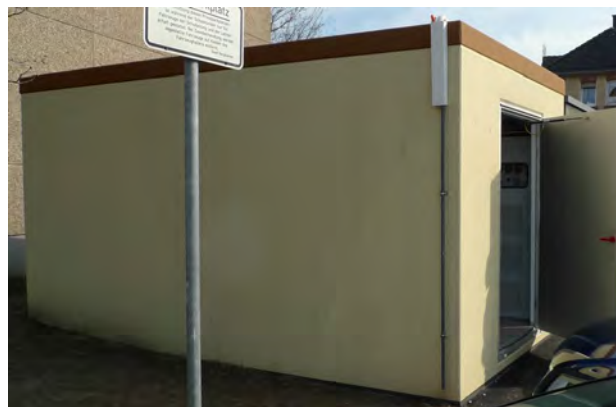
Abbildung 13: Ortszentrale in einem Container
