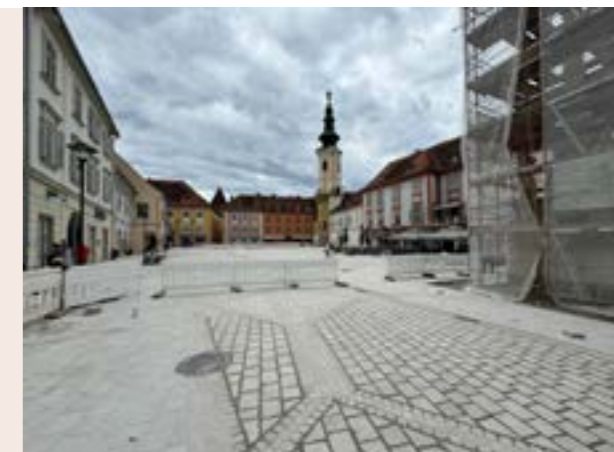
Bauphase neue Pflasterung und Mariensäule
